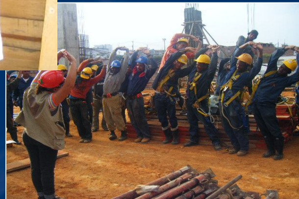
Obra Homecenter Bucaramanga
