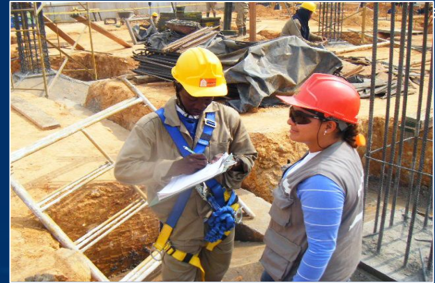
Obra Homecenter Bucaramanga
