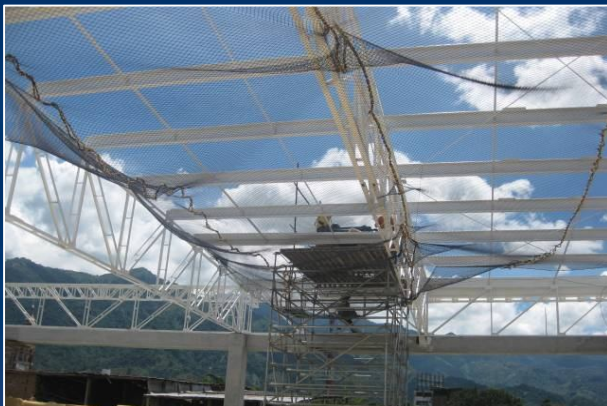
Obra Carrefour Ibagué
