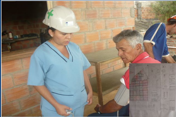
Obra Homecenter Bucaramanga
