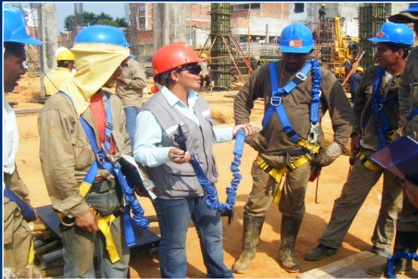
Obra Homecenter Bucaramanga
